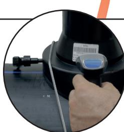
Подключите адаптеры сварочного аппарата к седелочному отводу, считывая штрих-код. После сварки, не снимать зажимное устройство до окончания времени охлаждения.
