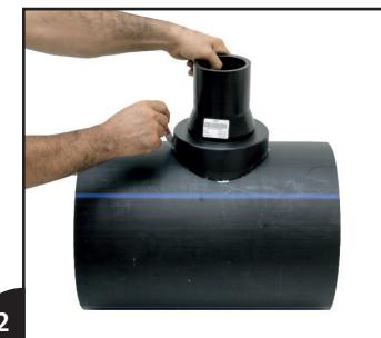
**EF Semeri boru üzerinde kaynak yapılacak bölgeye yerleştirin ve EF semeri içten ve dıştan işaretleyin.**
