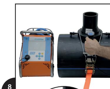
**EF kaynak makinesinin uçlarını EF semere bağlayın ve barkodu okutarak kaynağı yapın. Kaynak işleminden sonra, soğuma süresi kadar sıkma aparatını çıkarmayın.**
